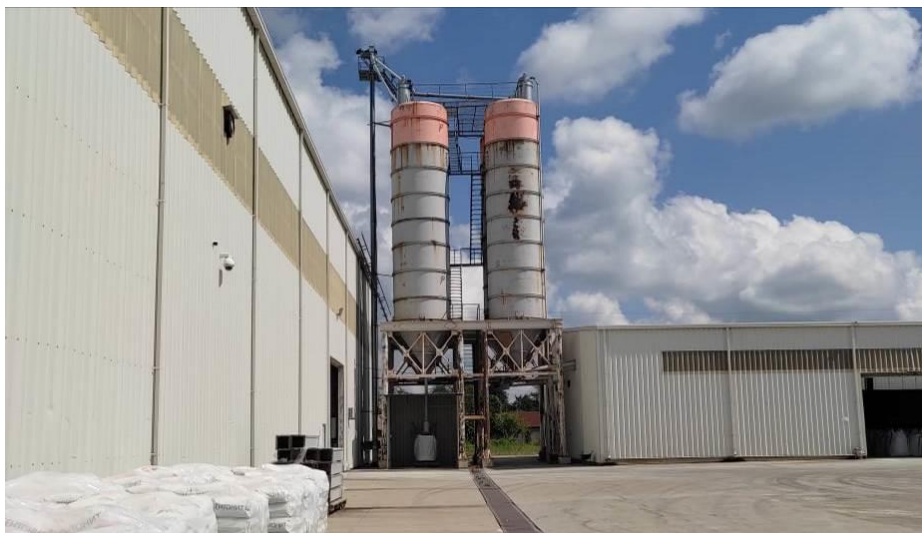
სურათი 2.3.3.4. 4 ც სამარაგო სილოსი (თითოეული 100 ტ)
